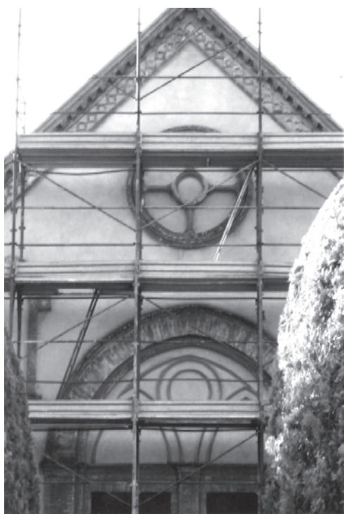
Restauri alla chiesa del cimitero
