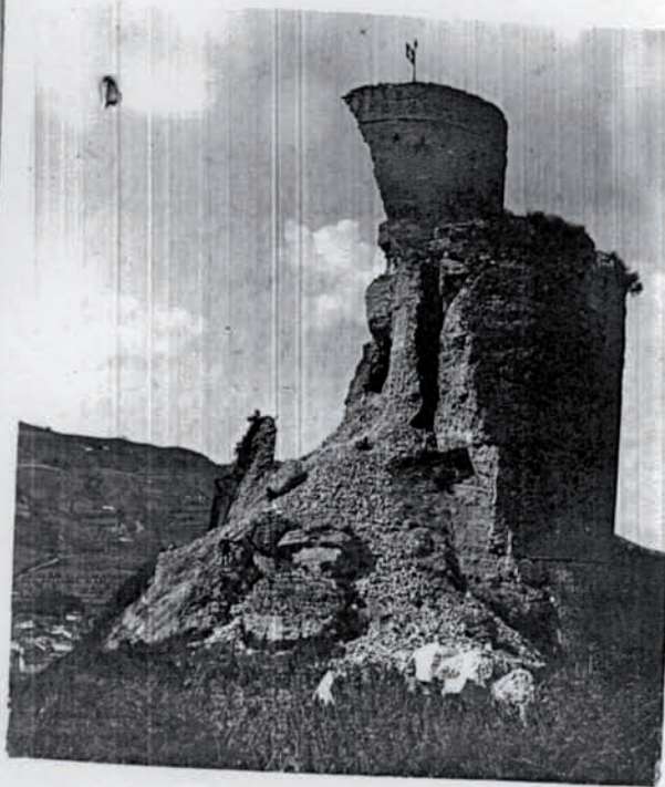
La Rocca - Dopo il crollo
